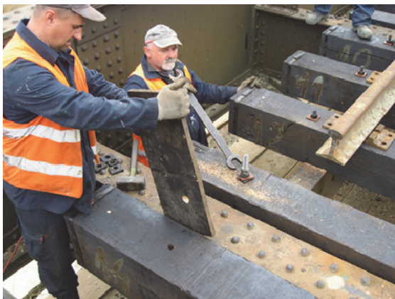
Slika 1. Pričvršćivanje drvenih pragova na čeličnu mosnu konstrukciju
